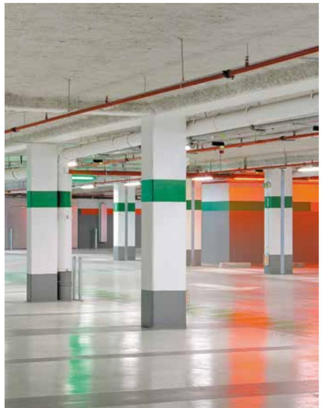
*Thermische Losung, Brand durch Fibrexpantm, unbehandeltes Finish.*
